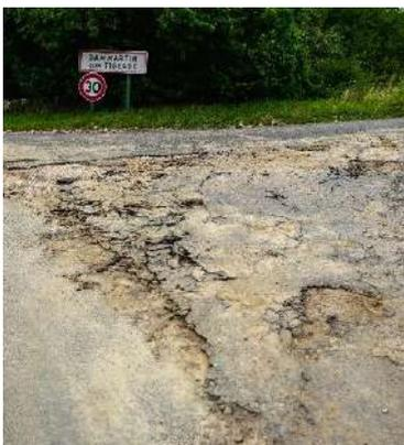
Figure 37 : Route détruite par le ruissellement à Dammartin
