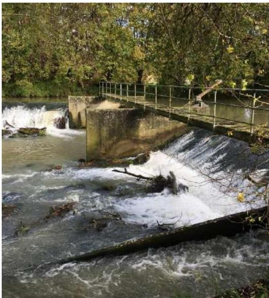
Figure 14 : Photographie du clapet et du déversoir de Mouroux
